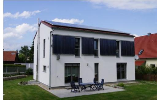
Die 18 m<sup>2</sup> Röhrenkollektoren für die thermische Solarenergienutzung sind an der Fassade und 43 m<sup>2</sup> Photovoltaikanlage auf dem Dach montiert
