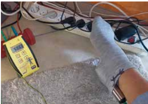
Hier nahe am Verteilerstecker 5060mV (5,06Volt)
