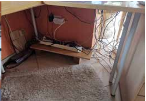
Abhilfe: Verteilerstecker nach oben somit findet kein Kontakt mehr mit den Füßen statt
